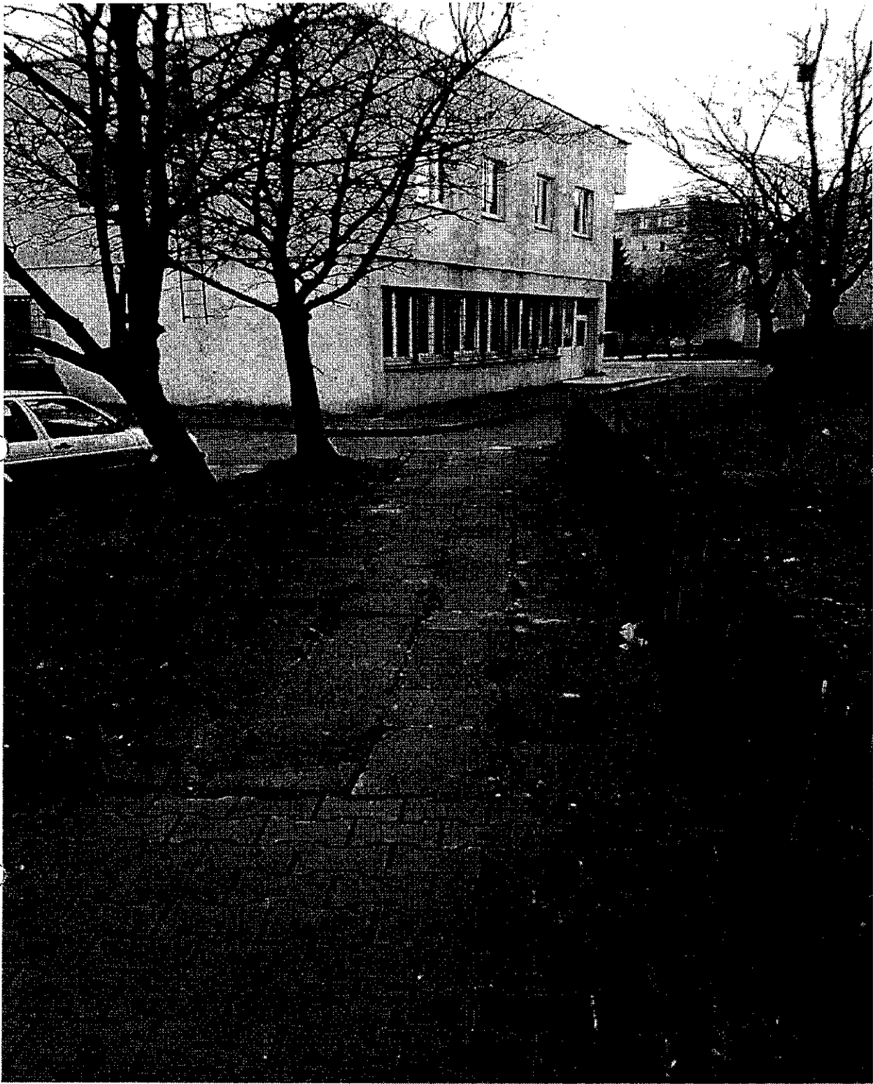
CHODNIK PRZY BUDYNKU SZWOLEŻERÓW 10
