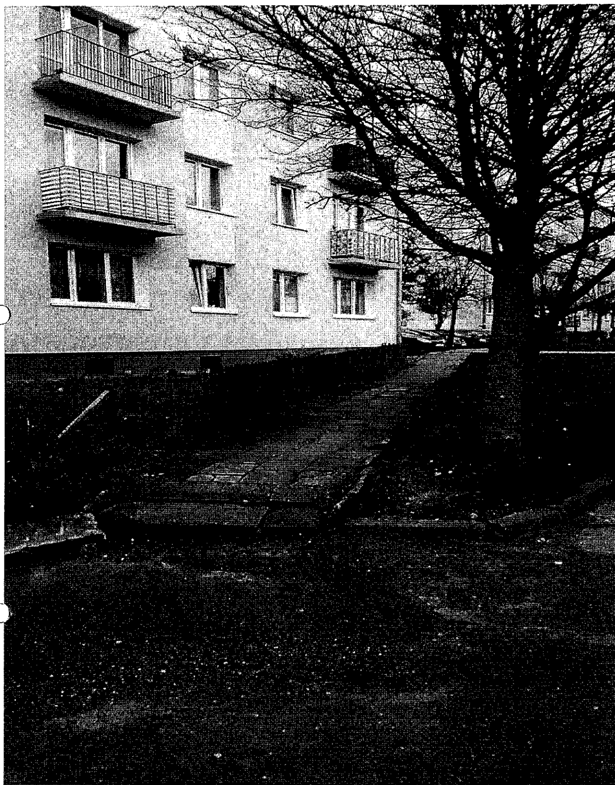
CHODNIK PRZY BUDYNKU SZWOLEŻERÓW 10
